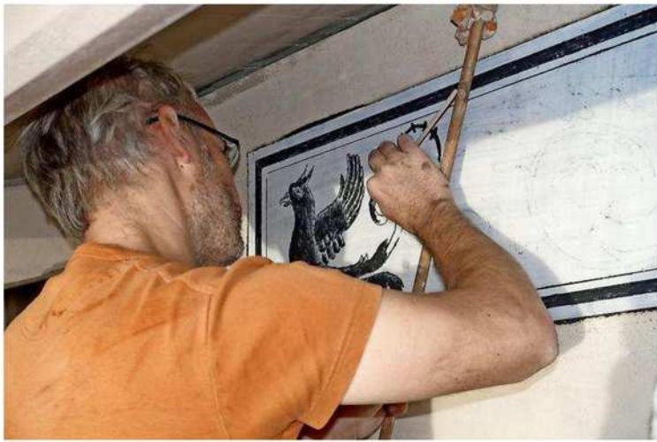
Restaurator Henry Lehmann fertigt in mühevoller Arbeit die dem Original nachempfundenen Sgraffiti an. Quelle: Stetzler Architektur
