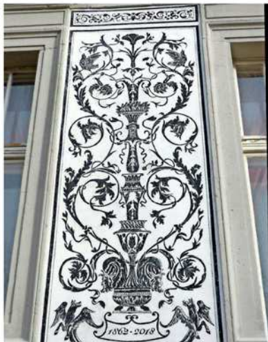
Eine Detailaufnahme der neu angefertigten Sgraffiti. Quelle: Genia Bleier
