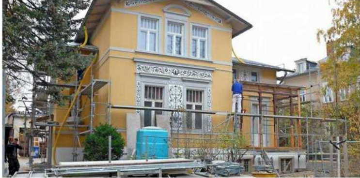
Das 1862 errichtete Haus im Schweizer Landhausstil an der Stolpener Straße erhält seine Originalfassade mit den Sgraffiti zurück. Auch die Veranda wird restauriert und moderat modernisiert. Quelle: Genia Bleier
